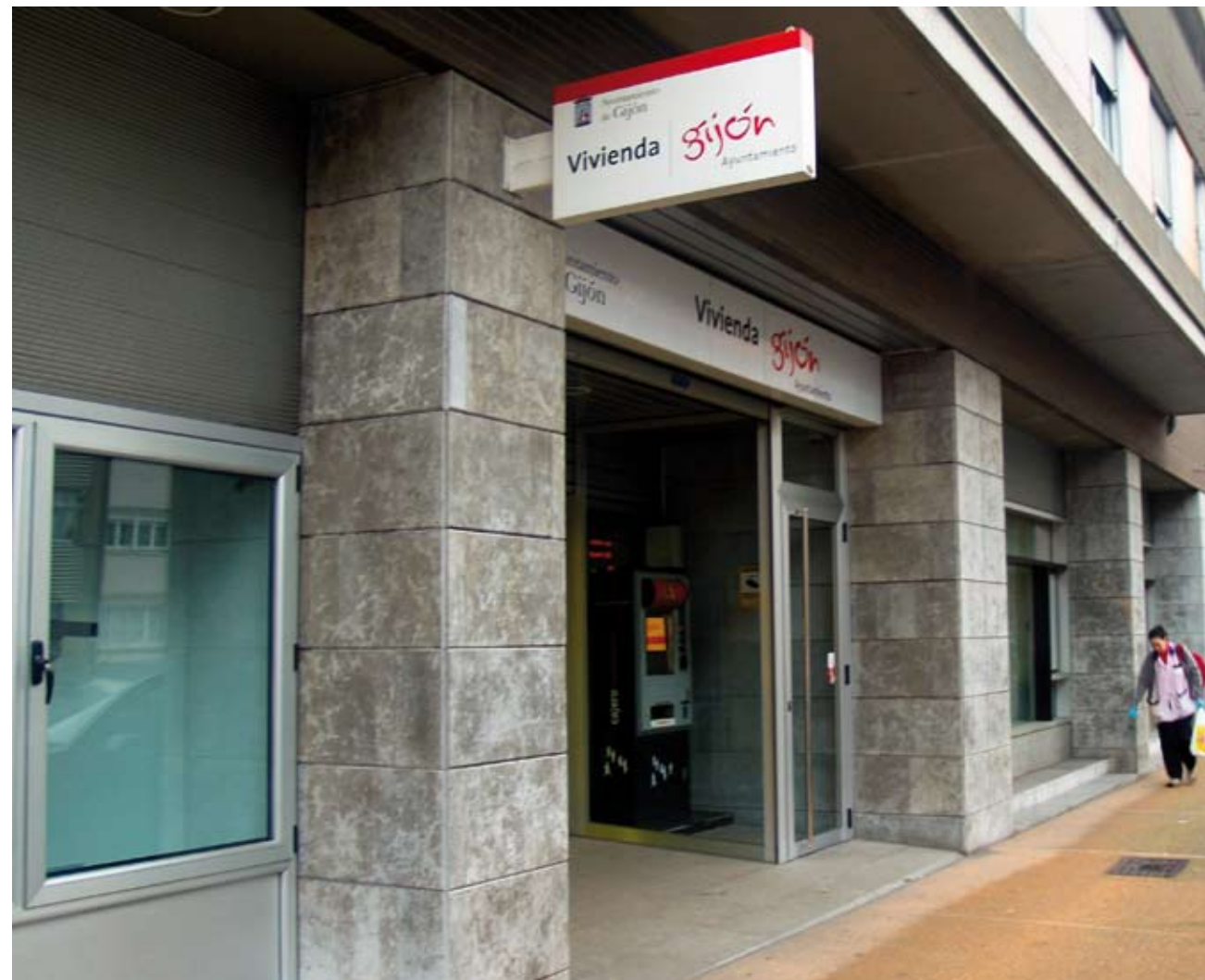
Sede de la Empresa Municipal de la Vivienda.
